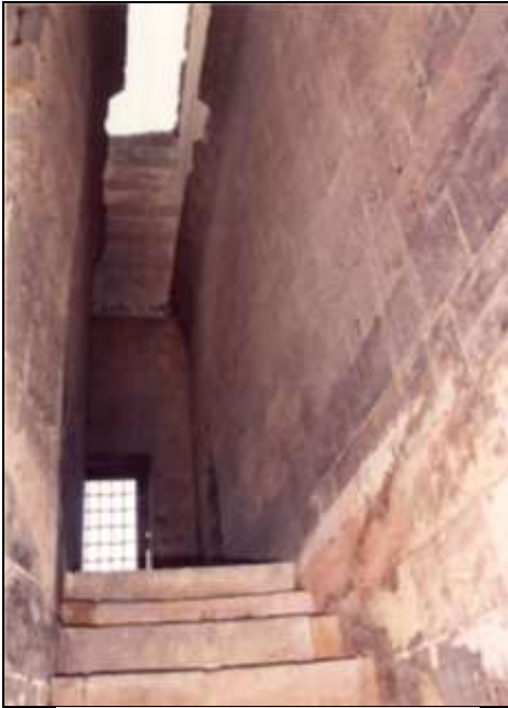
لوحة ٢٩ - الممر الفاصل بين الرباط وقبة طراباي - قبل الترميم
