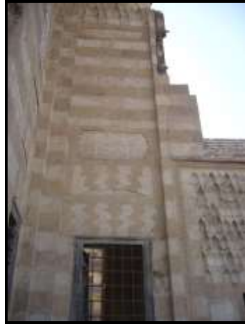
لوحة ٦ - واجهة الممر الفاصل بين مدخل الرباط وقبة طراباي من الجهة الجنوبية الشرقية - بعد الترميم
