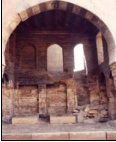
لوحة ١٦ - الإيوان الجنوبي الغربي للرباط - قبل الترميم
